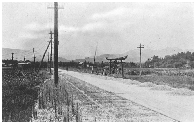
嵐電開業当時の蚕ノ社付近
